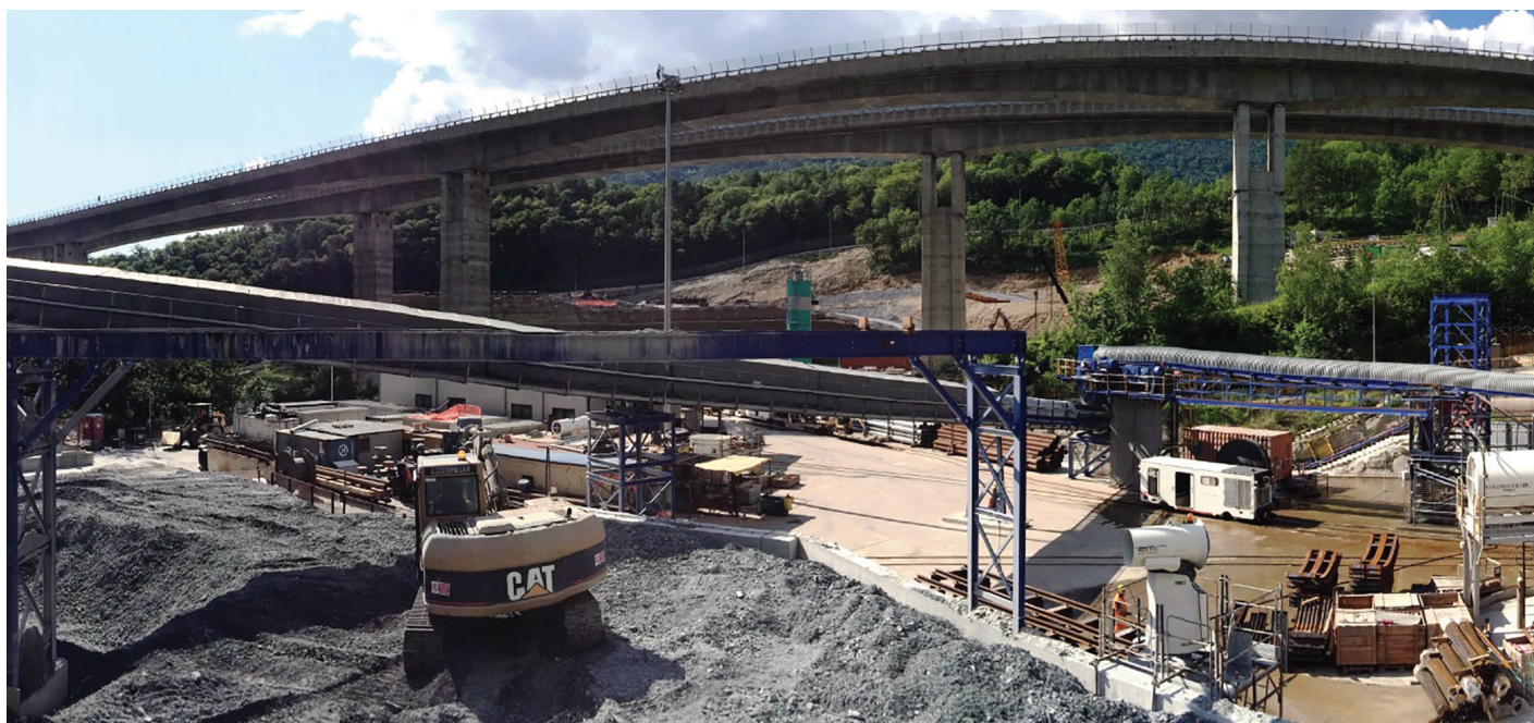
3. Cantiere TAV Torino – Lione – Cunicolo esplorativo La Maddalena - 2018
