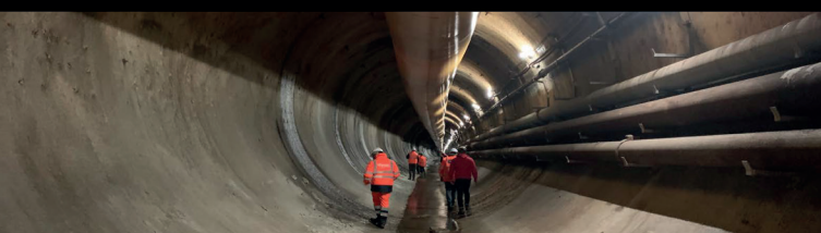
ASSISTENZA AMBIENTALE DI CANTIERE
